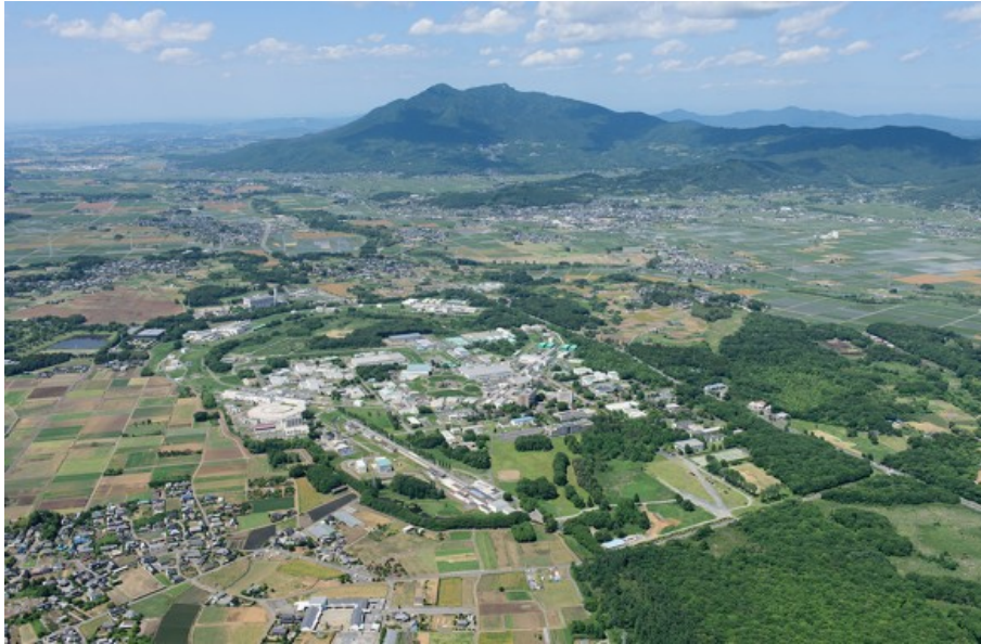
図 1.1 高エネルギー加速器研究機構 空中写真
