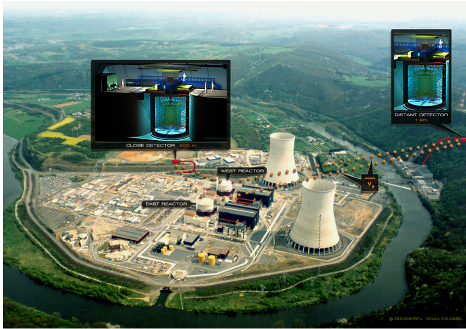
図 2.2 原子炉と Double Chooz 検出器の配置。図中の左側に示されているのが前置検出器、川を挟んだ右奥側が後置検出器である。右手の大きな建物は冷却設備で、原子炉は中央に 2 つ並んだ小さな丸い建物である。
