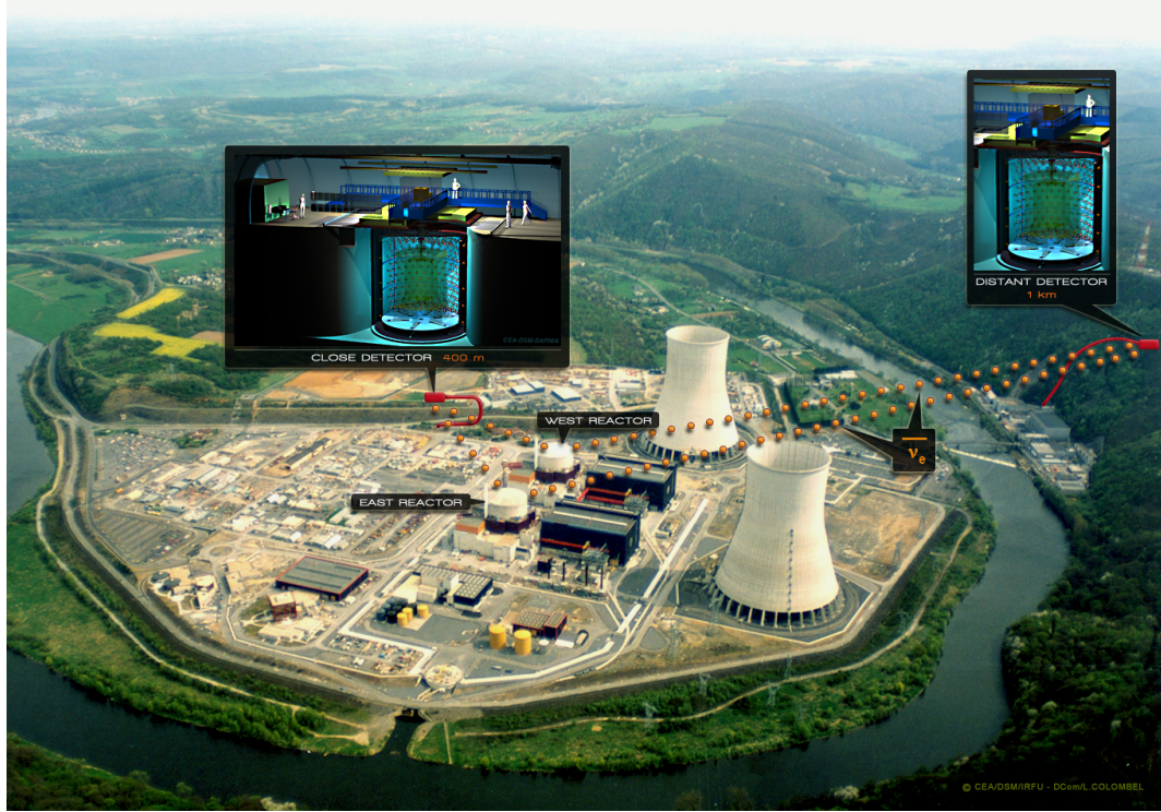
図 2.1: Chooz 原子力発電所鳥瞰図。図の中央に位置する二つの原子炉から発生する反電子ニュートリノを前置検出器 (図左側)、後置検出器 (図右側) で観測し、二つの測定データを比較することにより系統誤差を低減した \theta_{13} の精密測定を行う。
